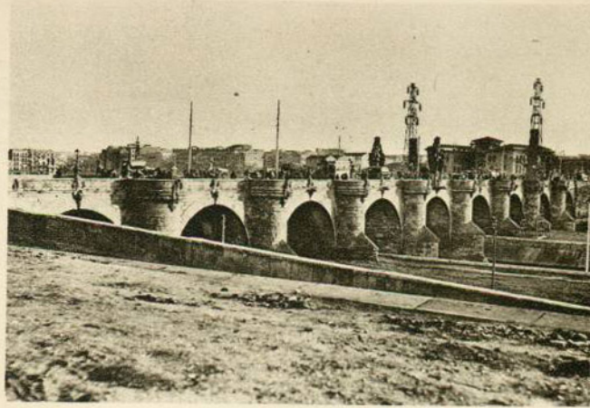
PUENTE DE TOLEDO (Madrid)
