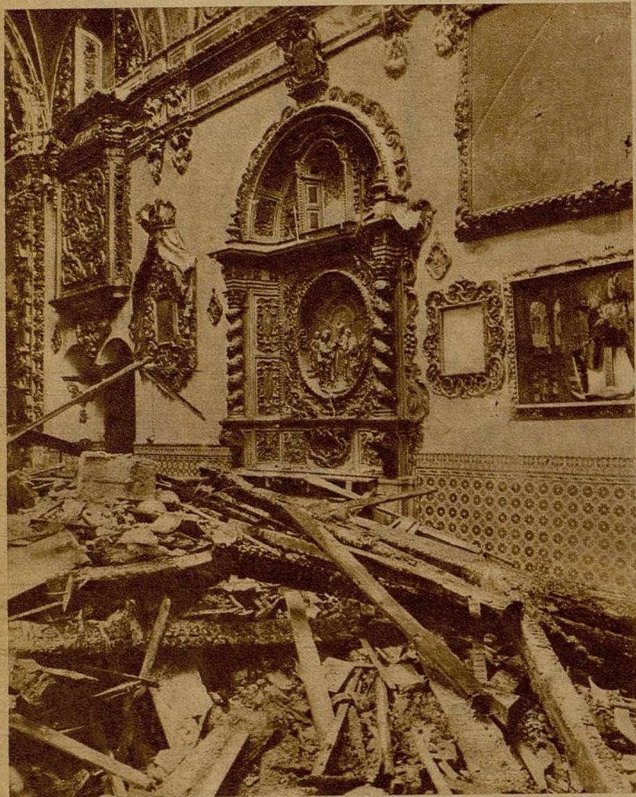
La capilla de San José, enclavada en la parte de la calle del General Polavieja, llamada popularmente "Las cuatro esquinas", ha sido pasto de las llamas en los desórdenes ocurridos en la noche del lunes. Véase el estado en que quedó la nave principal
