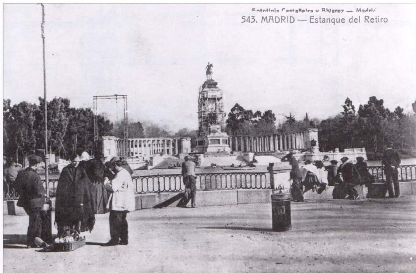
El monumento en construcción.
