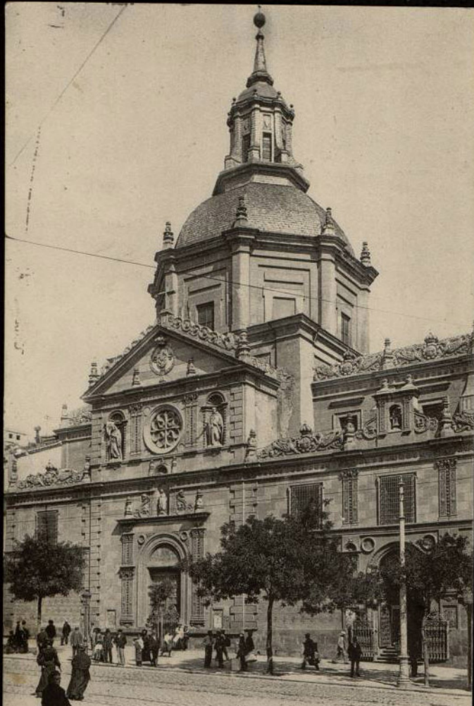
75 MADRID. — Iglesia de las Calatravas. Ayuntamiento de Madrid.
