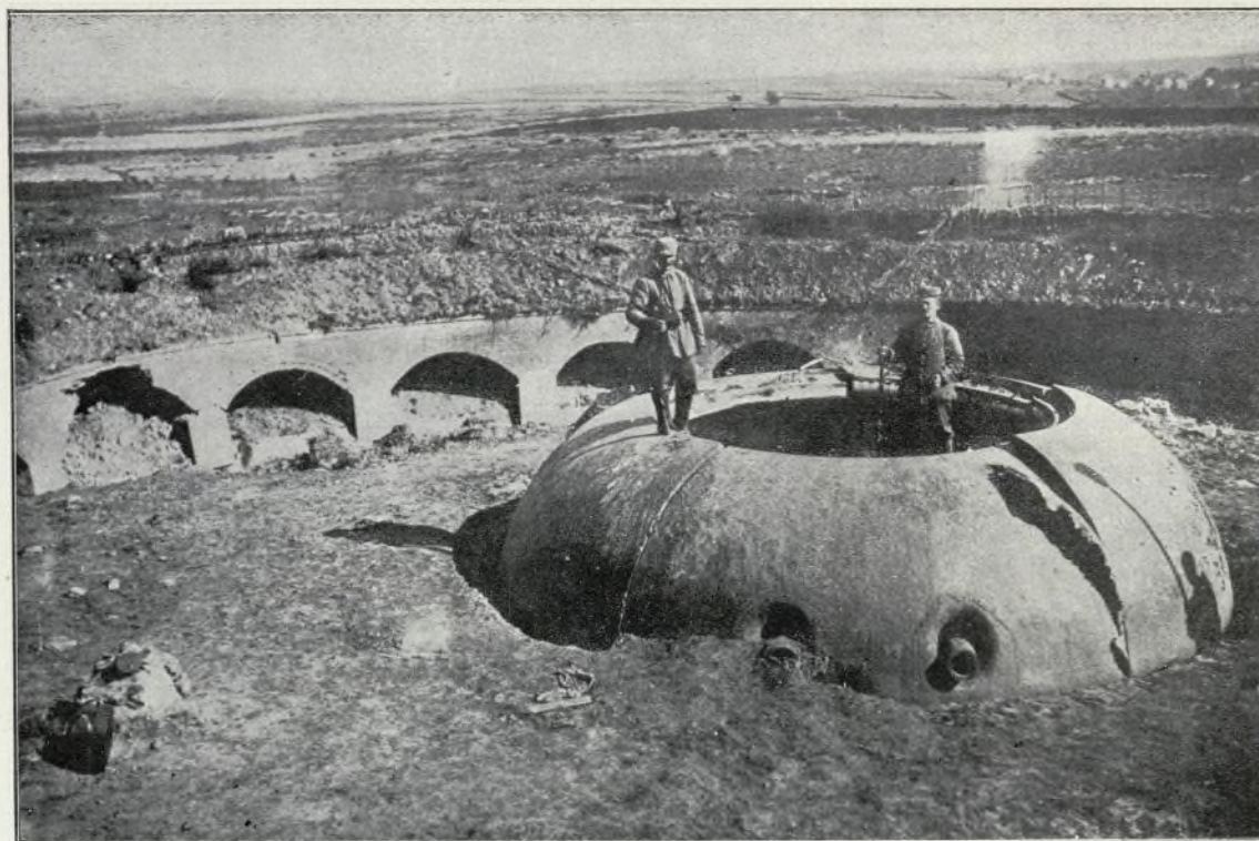
Efecto de un granada de 42 cent. en una cúpula de un fuerte de Maubeuge (Fot. Central News)
