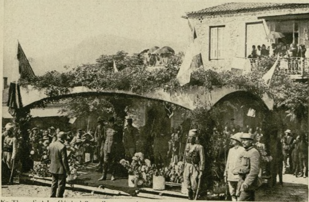
En Thessalie : Le Général Sarrail reçu par la municipalité d'un village. — In Thessalia : General Sarrail received by the village municipality. — In Tessaglia : Il Generale Sarrail ricevuto dalla Giunta comunale d'un villaggio. — Na Thessalia : O general Sarrail recebido pela municipalidade de uma aldeia. — En Tesalia : el general Sarrail recibido por la Municipalidad de una aldea. — In Thessalien : General Sarrail wird von der Obrigkeit eines Dorfes empfangen.
