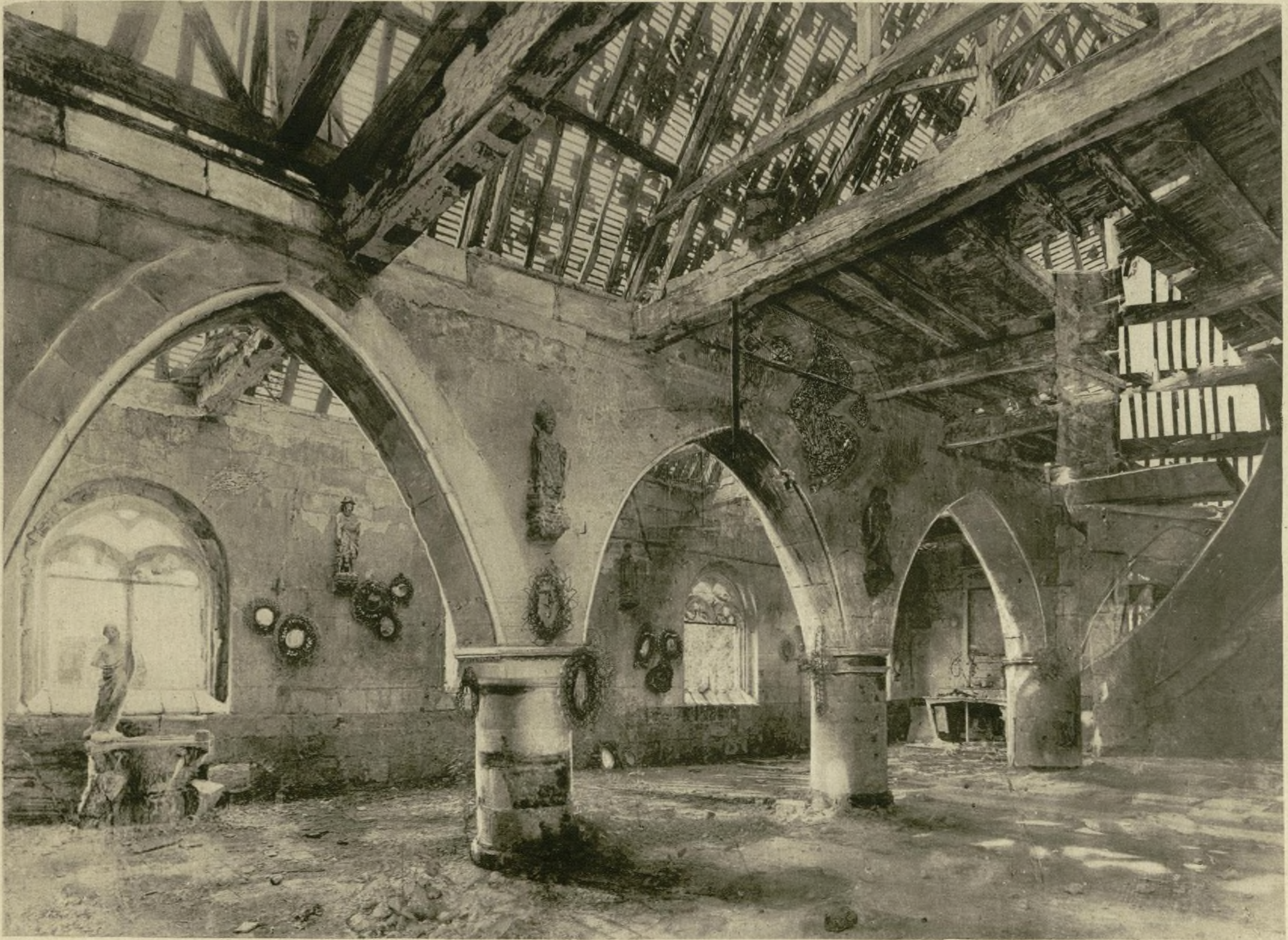
L'Eglise de Canectancourt après la retraite allemande. — The church of Canectancourt after the German retreat. — La chiesa de Canectancourt dopo la ritirata dei tedeschi. — A egreja de Canectancourt, após a retirada alemã. — La iglesia de Canectancourt después de la retirada alemana. — Die Kirche von Canectancourt nach dem Rückzug der Deutschen.
