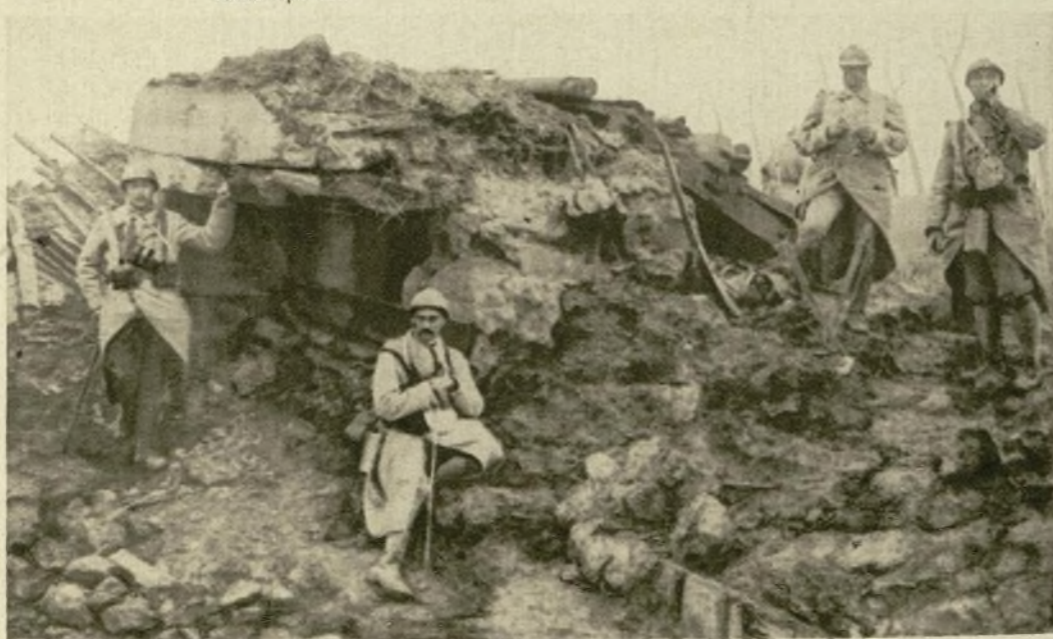
Près d'un blockhaus allemand détruit par l'artillerie française. — Near a German block-house which has been destroyed by French artillery. — Presso a un blockhaus tedesco distrutto dall' artiglieria francese. — Perto de um blockaus alemão destruído pela artilharia franceza. — Cerca de un « blockaus » alemán destruído por la artillería francesa. — Bei einem deutschen Blockhaus, das durch französische Artillerie zerstört wurde.
