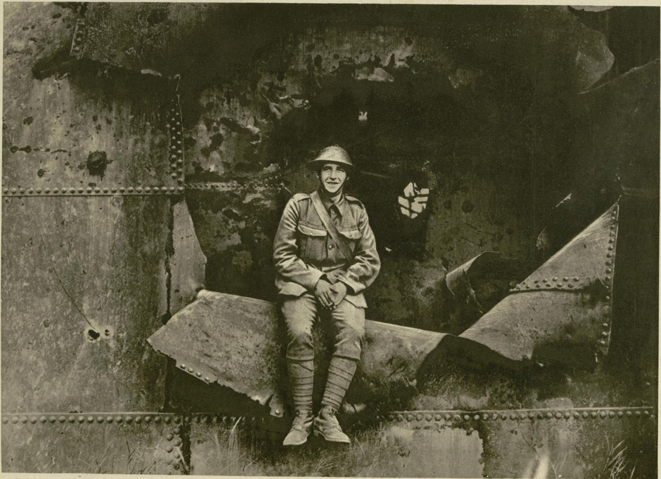
Gazomètre traversé de part en part par un obus anglais. — A British shell has pierced this gas-meter through and through. — Gasometro trafitto da un proiettile inglese. — Gazometro atravessado de um lado a outro por um projectil inglez. — Gasómetro atravesado de parte a parte por un proyectil inglés. — Ein von einem englischen Shrapnell durchbohrtes Gasometer.
