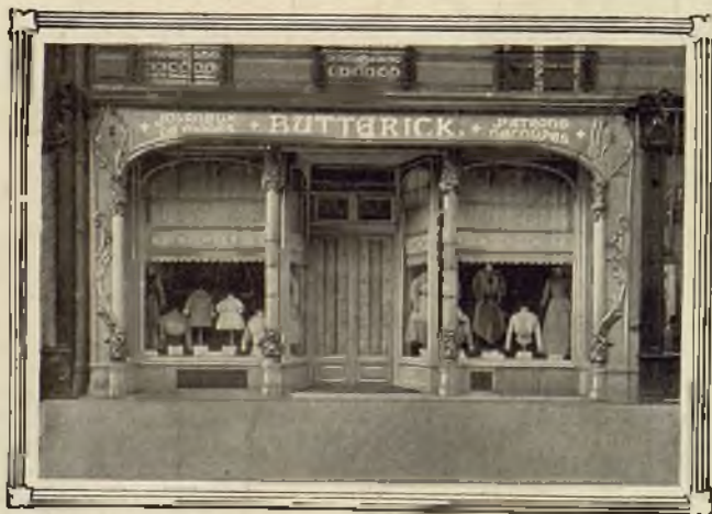
Façade de notre magasin, 27, avenue de l'Opéra
