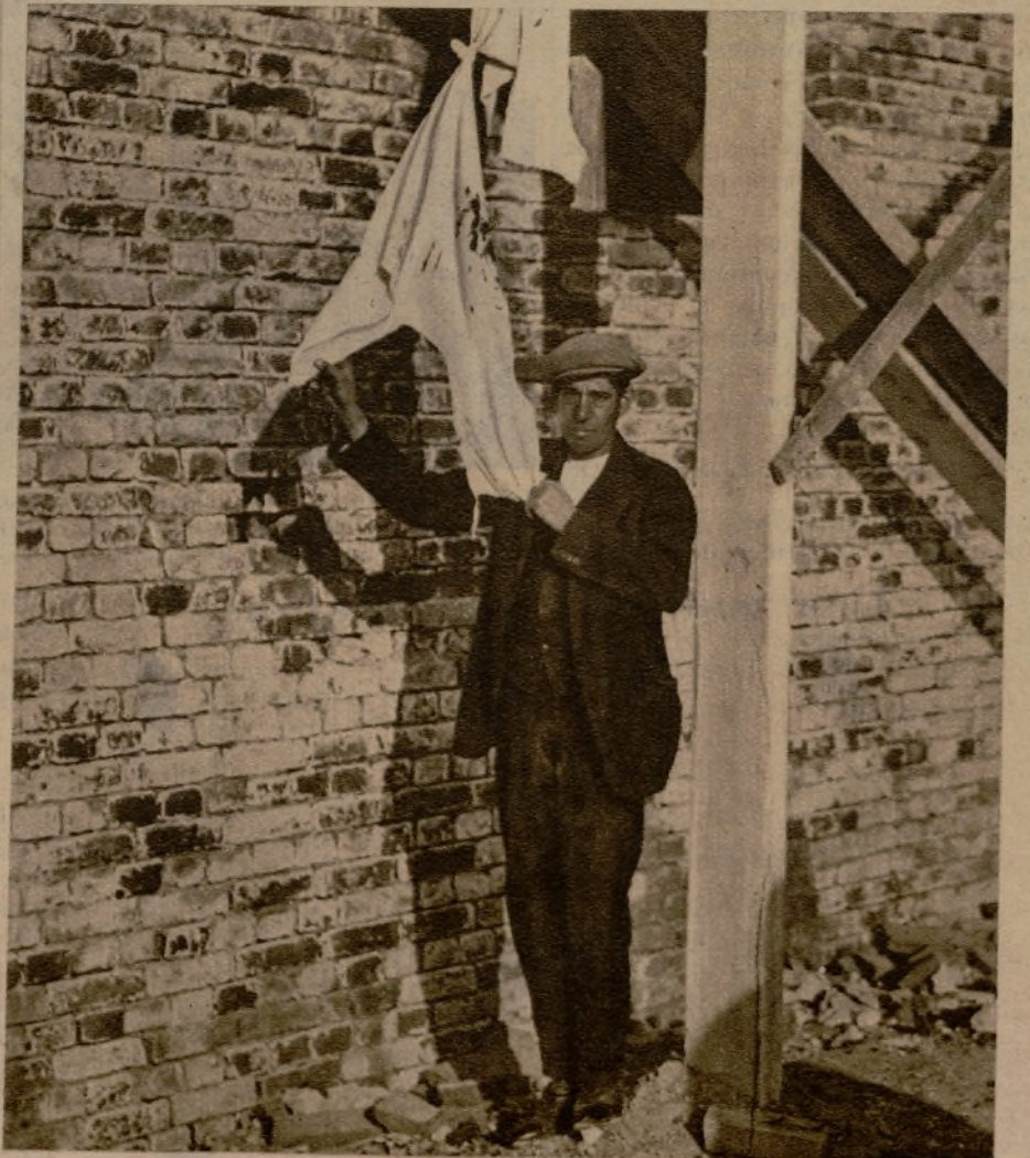
Un obrero muestra la camisa ensangrentada de su infortunado compañero muerto, que quedó prendida en uno de los palos del andamiaje.
