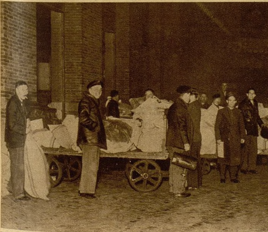
El andén principal de la estación está invadido por las carretillas, que dificultan el tránsito de los pasajeros
