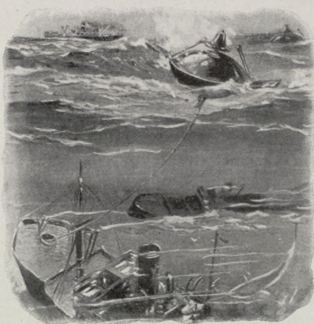
Una boya con campana sirve para fijar el sitio del barco hundido, facilitando su identificación en el caso de que por temporal, haya que suspender las operaciones de salvamento.
