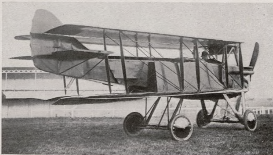
El autoavión, plegadas las alas, y en disposición de marchar como automóvil
