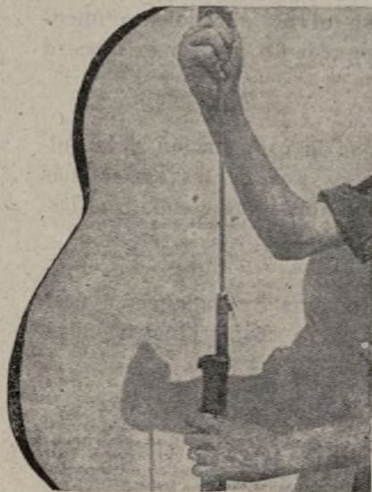
El cañón se limpia introduciendo con la baqueta, o por medio de una cuerda, un trapo seco.
