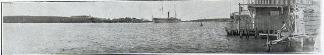
VISTA PARCIAL DE LA ENTRADA DEL PUERTO DE CIENFUEGOS.
