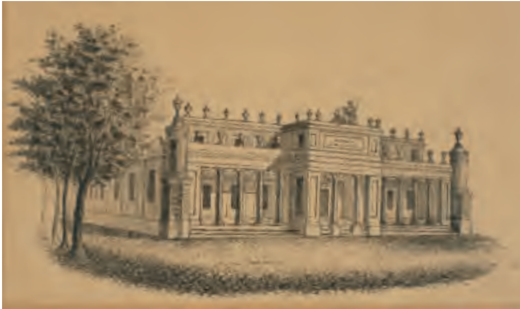
Fig. 92. Dibujo de la fachada principal de la fábrica a mediados del siglo XIX. Museo de Historia. Madrid.
