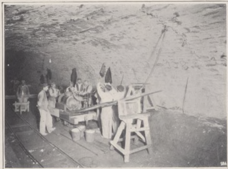
MACHINE A INJECTER LE MORTIER DERRIÈRE LES MAÇONNERIES
