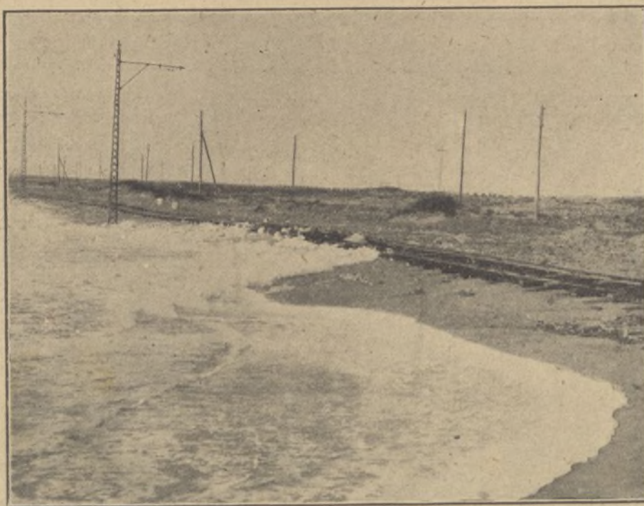
Destrozos causados por el temporal en la vía férrea de Cádiz á San Fernando. (Fot. Flórez.)
