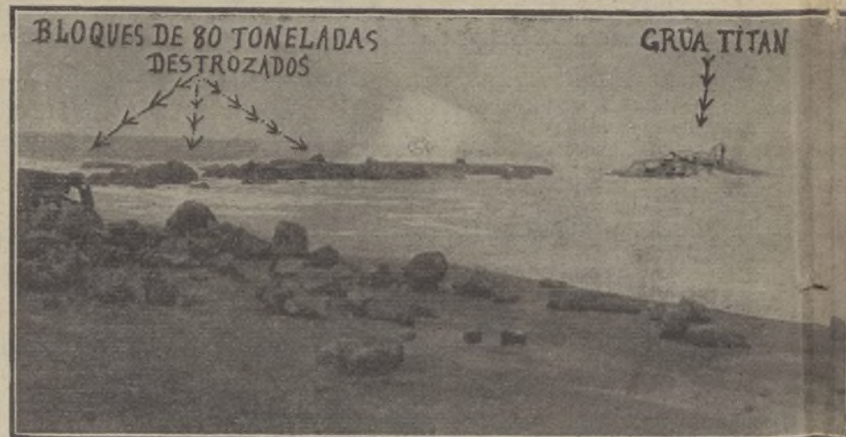
El puerto de Melilla destruído por el temporal. La grúa Titan y los bloques de 80 toneladas destruídos
