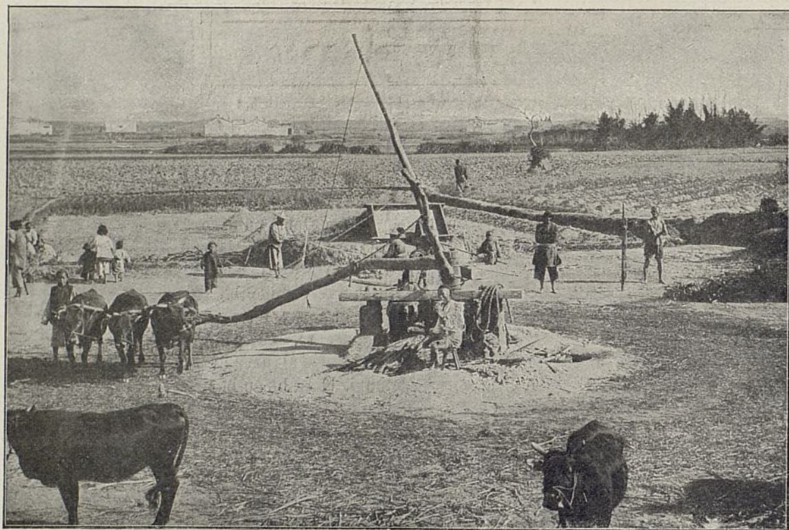
KOUANG-TONG (CHINA).—Aparato para obtener el jugo de la caña de azúcar.—Reproducción de fotografía enviada por M. Bouspis
