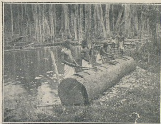
AFRICA PINTORESCA.—GUINEA ESPAÑOLA: PREPARANDO UN BOKUME, HERMOSO Y UTILÍSIMO ARBOL DE NUESTRA GUINEA CONTINENTAL, PARA EL EMBARCO. A GOLPE DE HACHA LE HACEN CUATRO CARAS.—Reproducción directa de fotografía enviada por el R. P. Marcos Ajuria, C. M. F.
