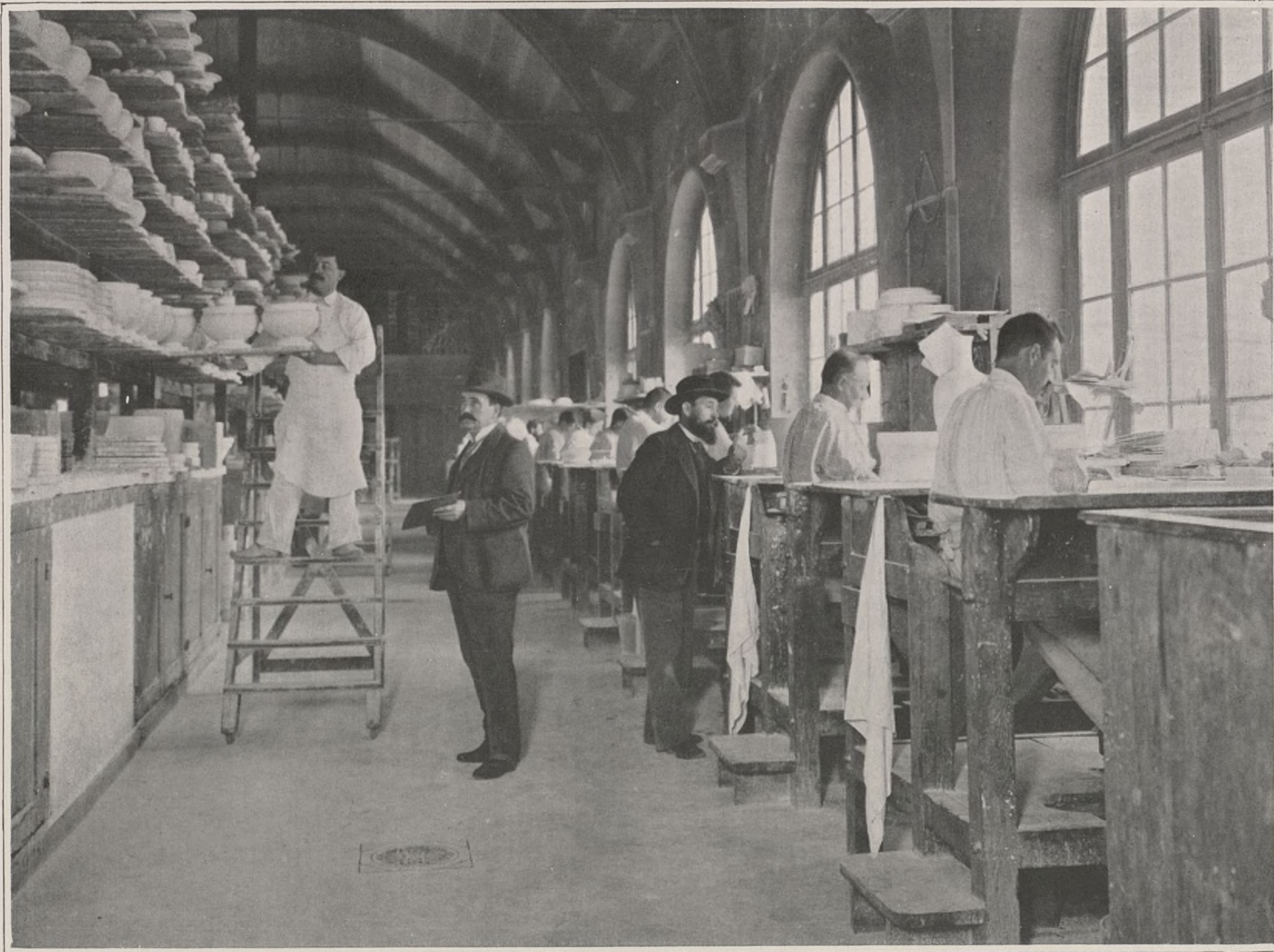
A LA MANUFACTURE DE SÈVRES. — L'ATELIER DES TOURNEURS DE PORCELAINES
