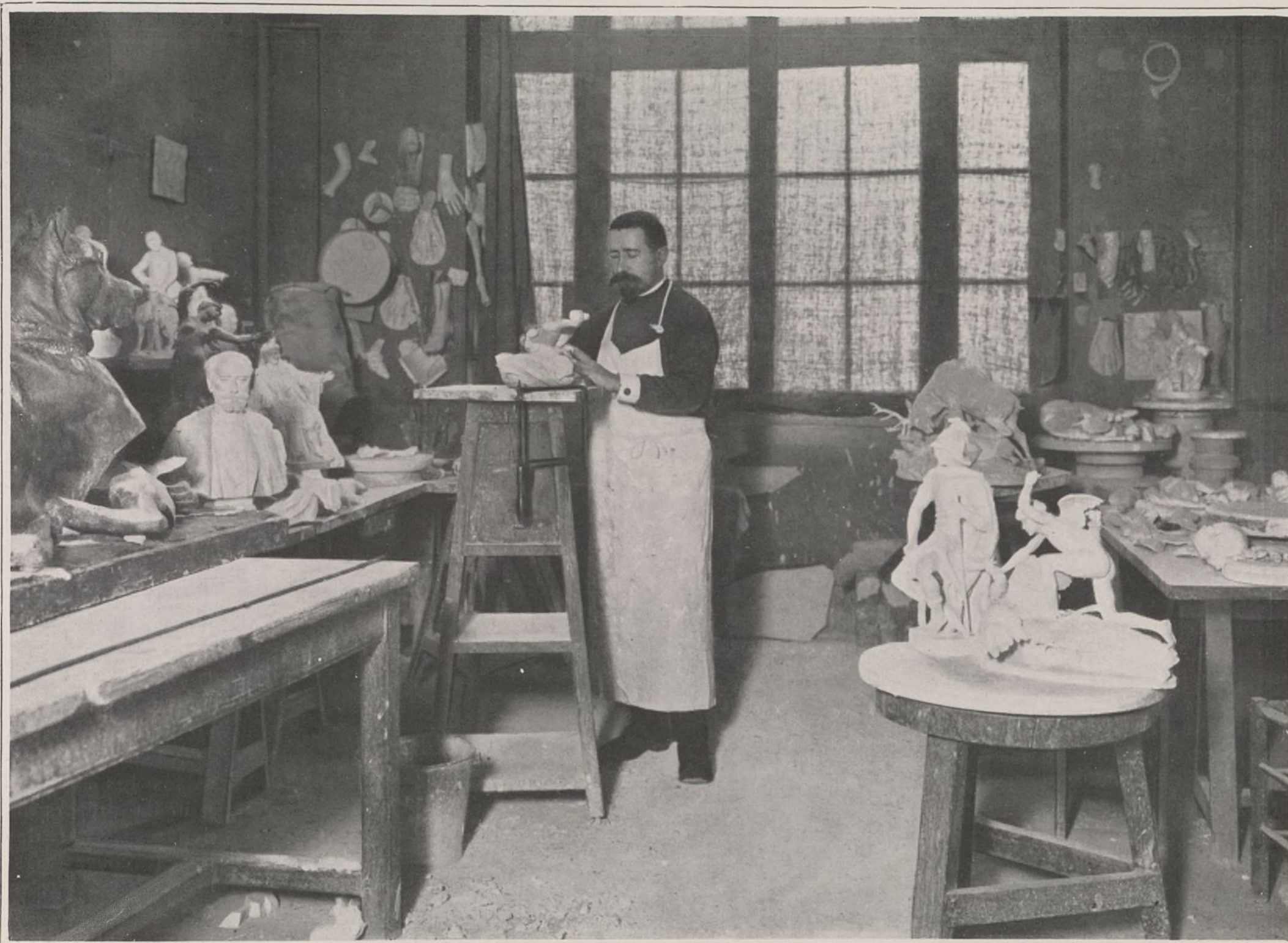
A LA MANUFACTURE DE SÈVRES. — UN ATELIER DE DÉCOUPAGE DES MODÈLES DE SCULPTURE POUR LA FABRICATION DES MOULES
