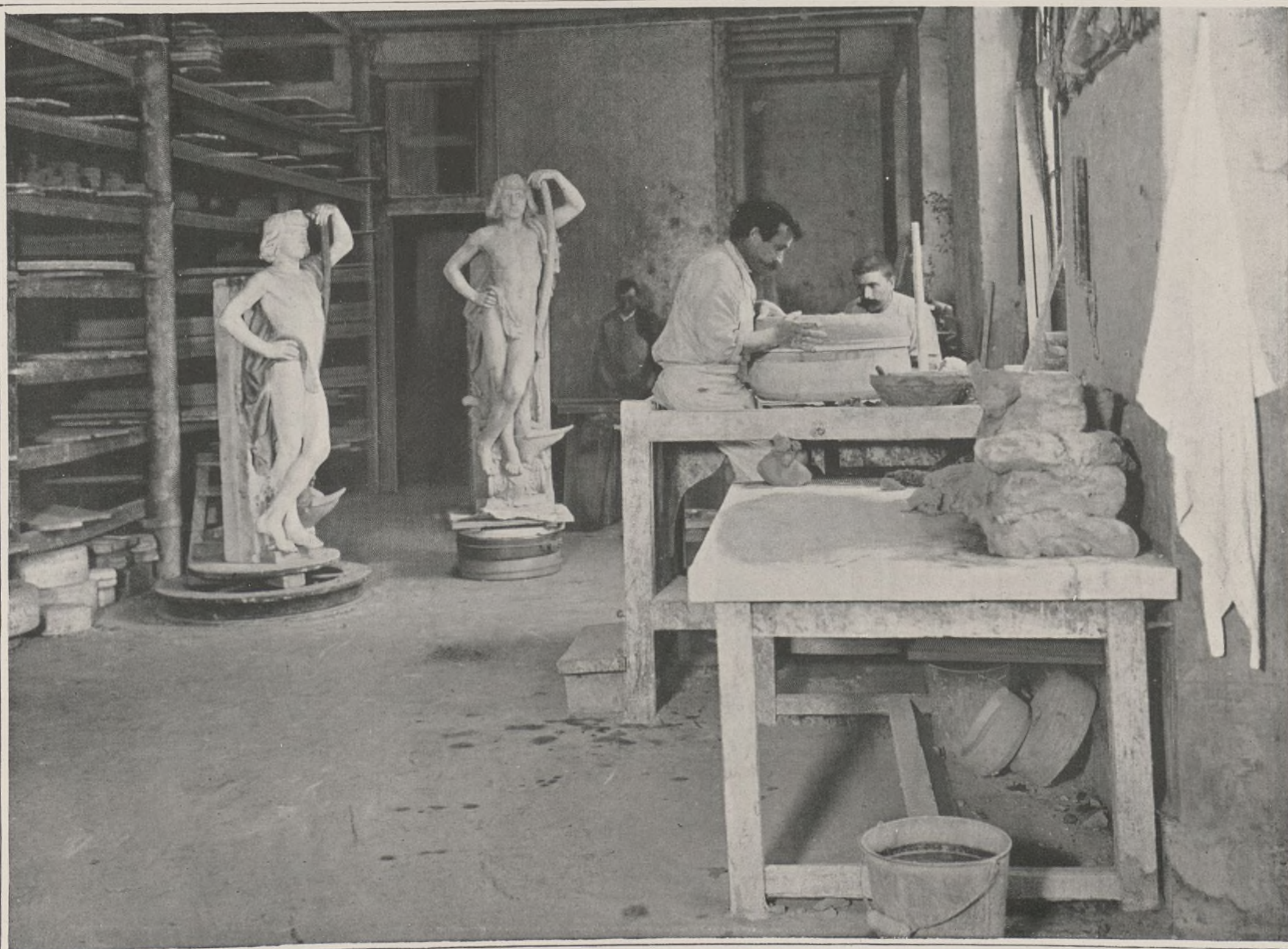
A LA MANUFACTURE DE SÈVRES. — ATELIER DES « CASSETTES » OU ÉTUIS DANS LESQUELS SONT RENFERMÉES LES PIÈCES DE PORCELAINES PENDANT LA CUISSON
