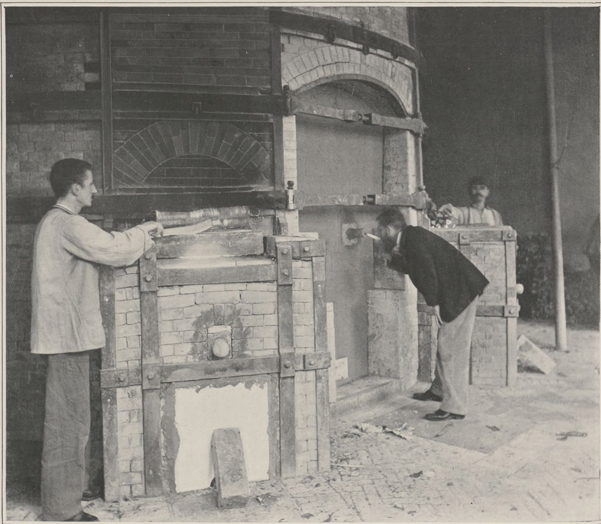
A LA MANUFACTURE DE SEVRES. — CUISSON D'UNE FOURNÉE DE PORCELAINE DURE
