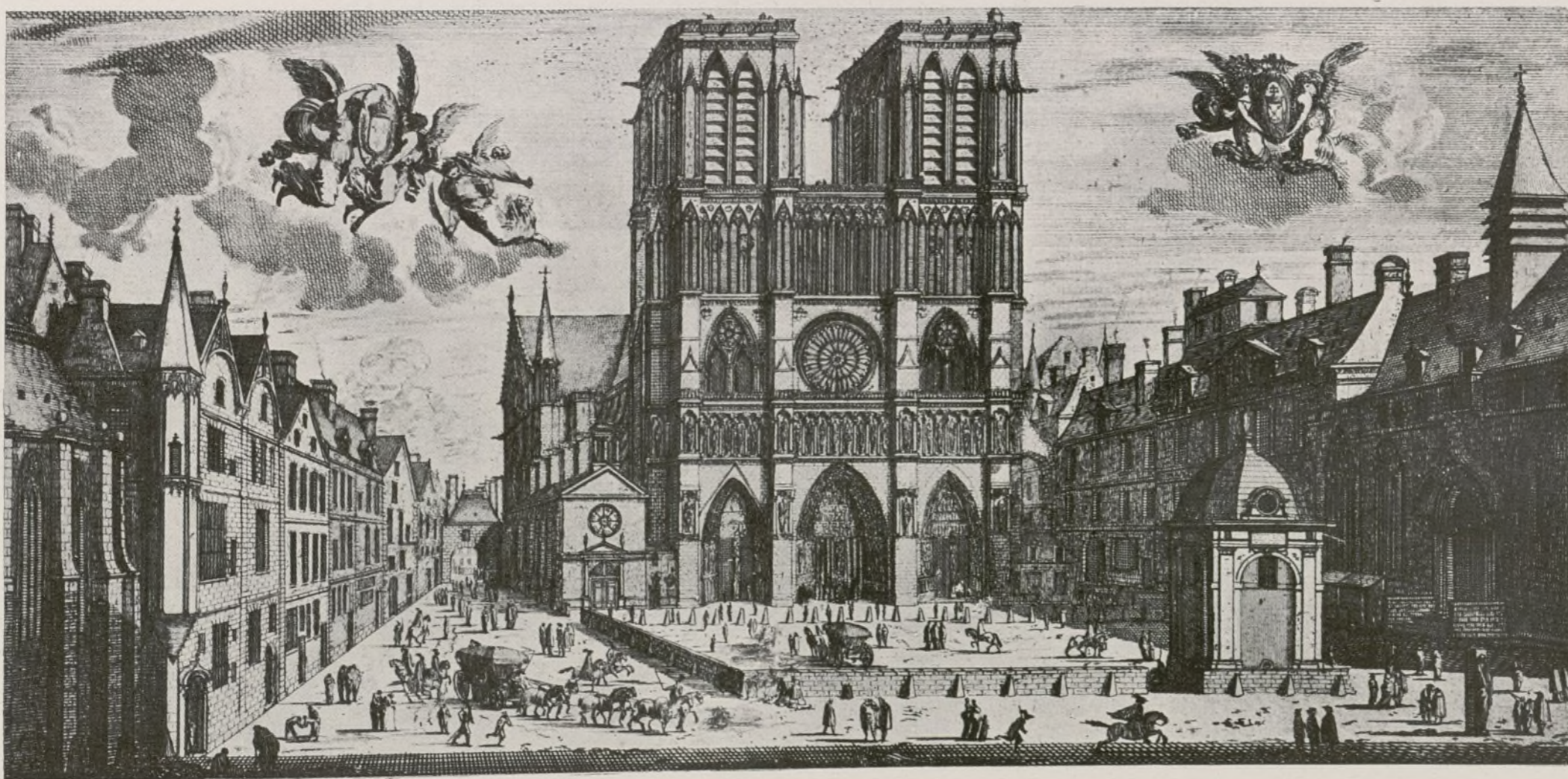
Vue de la principale entrée de l'Eglise de NOSTRE DAME, de Paris, Bâtie sous le Règne de Philippe Auguste environ l'an 1200, Tout cet édifice est fondé sur Pilotis et creux par dessous en plusieurs endroits, la hauteur des Tours ou Clochers est de 65 Toises, Ce lieu est estimé le plus bas de Paris. (Van Merlen ex)
