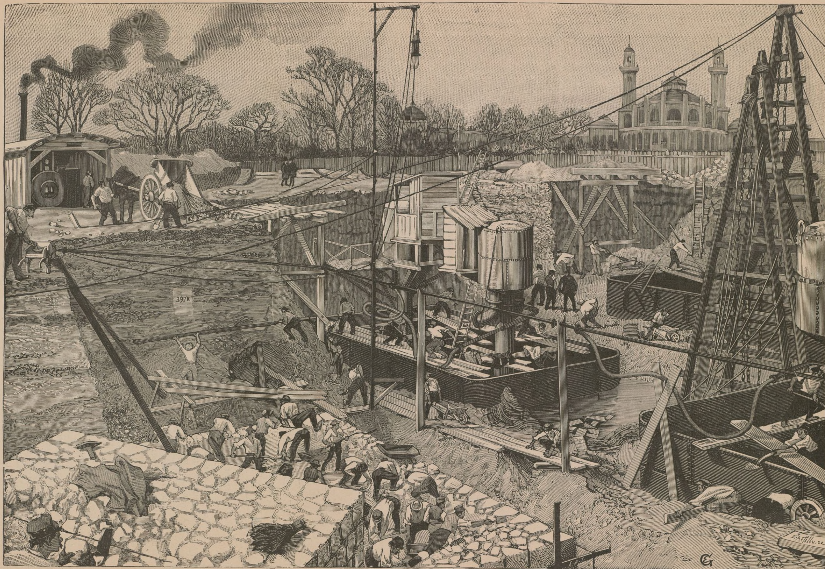
LA TOUR EIFFEL. — TRAVAUX DE FONDATION ET DE CONSOLIDATION DES PILES
