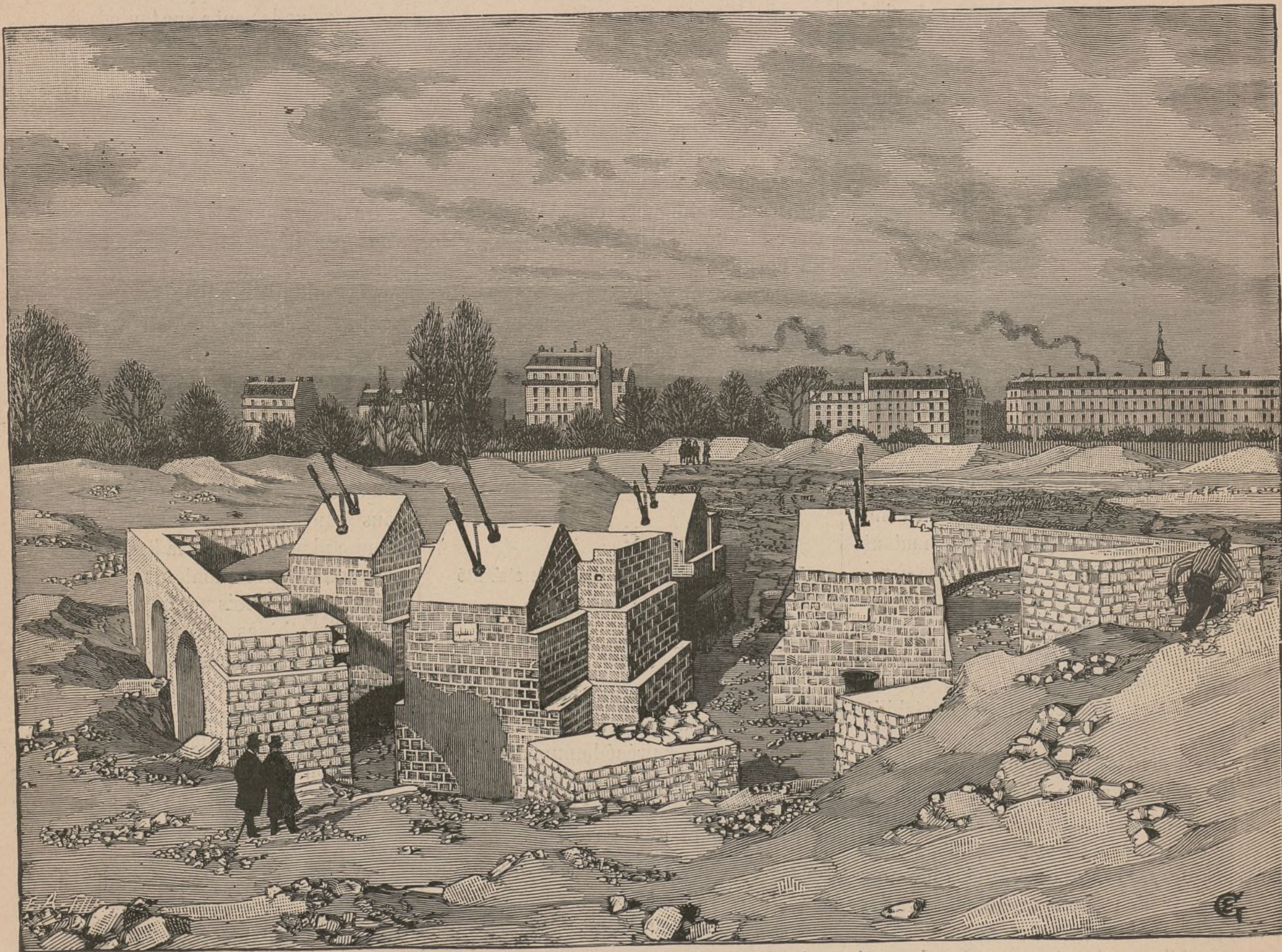
LES FONDATIONS DE LA TOUR EIFFEL. — PILE D'UN PIED DU COTÉ DE L'ÉCOLE MILITAIRE
