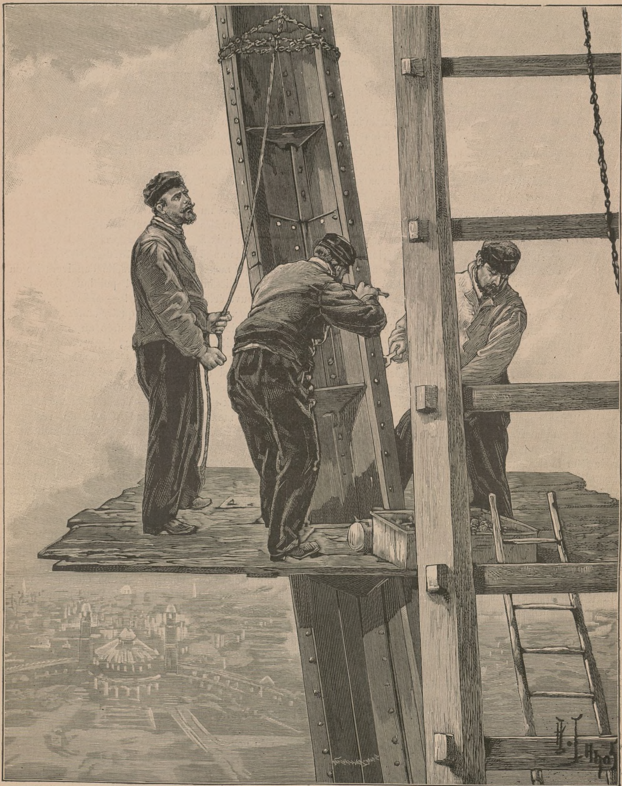
LES TRAVAUX DE LA TOUR EIFFEL. — A 180 MÈTRES EN L'AIR. — BOULONNAGE DU JOINT DES DEUX ARBALÈTRIERS
