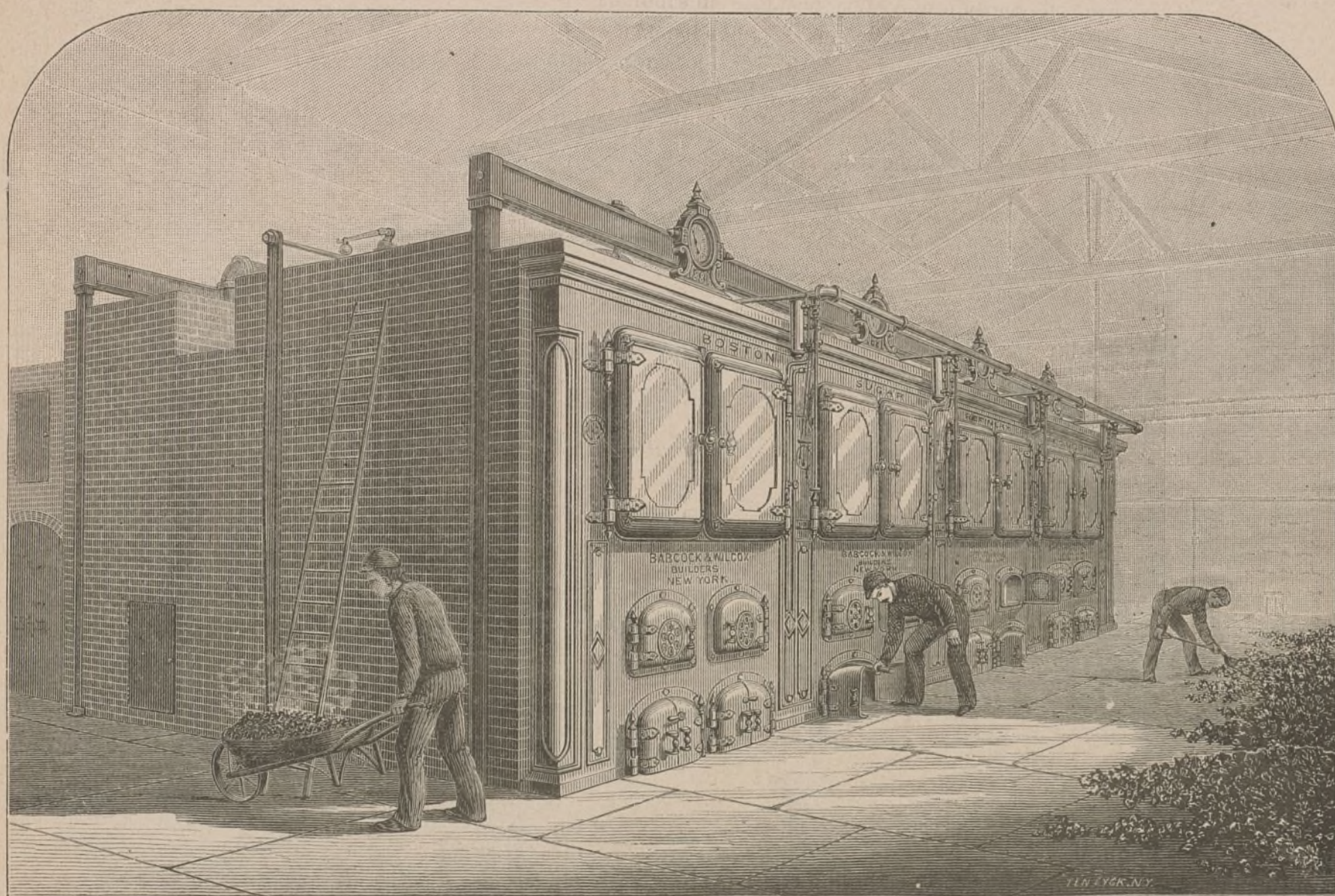
Fig. 2. — CHAUDIÈRES BABCOCK ET WILCOX.
