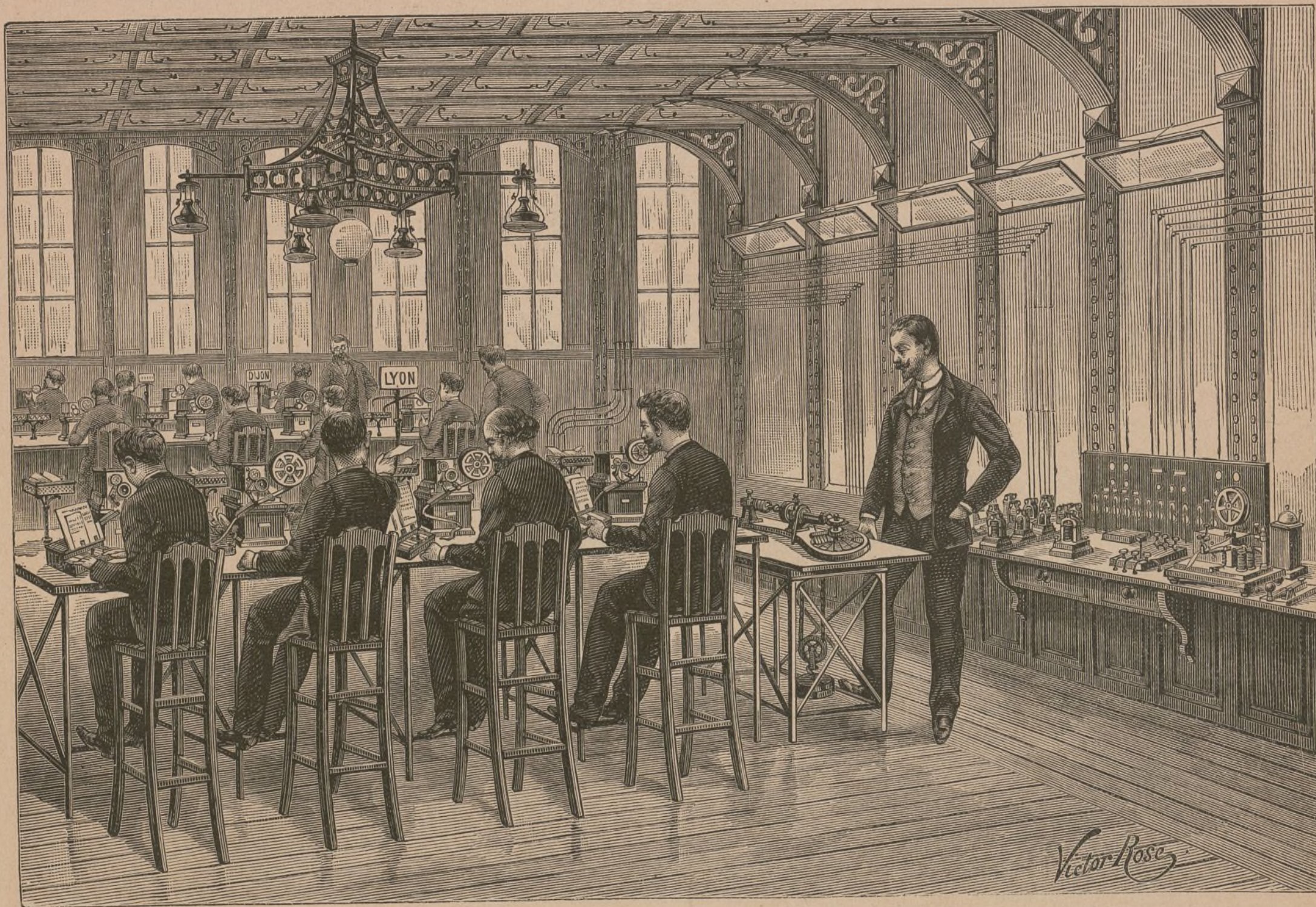
Fig. 2. — UN POSTE DU TÉLÉGRAPHE MULTIPLE BAUDOT, AU BUREAU CENTRAL DES TÉLÉGRAPHES DE LA RUE DE GRENELLE, A PARIS.
