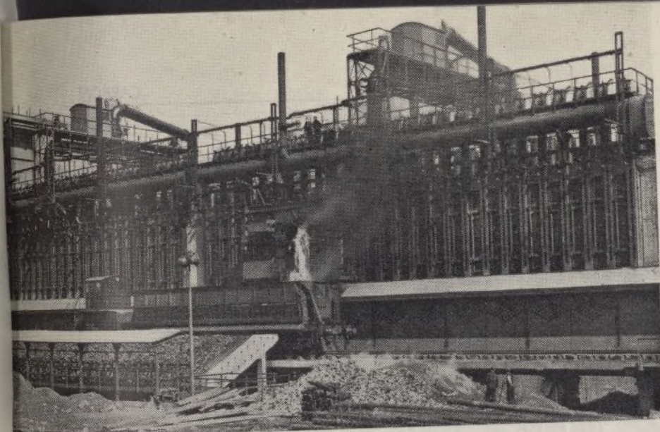
Fotografía de una instalación típica de hornos de cok de productos derivados ilustrando la operación de descarga de un horno de cok.
