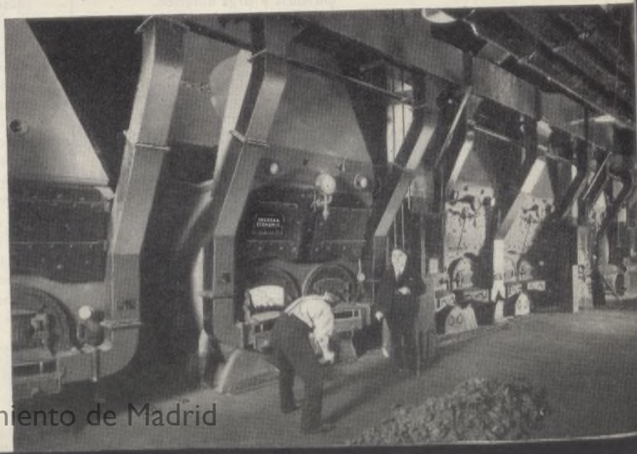
Algunas de las calderas alimentadas con carbón de cok.
