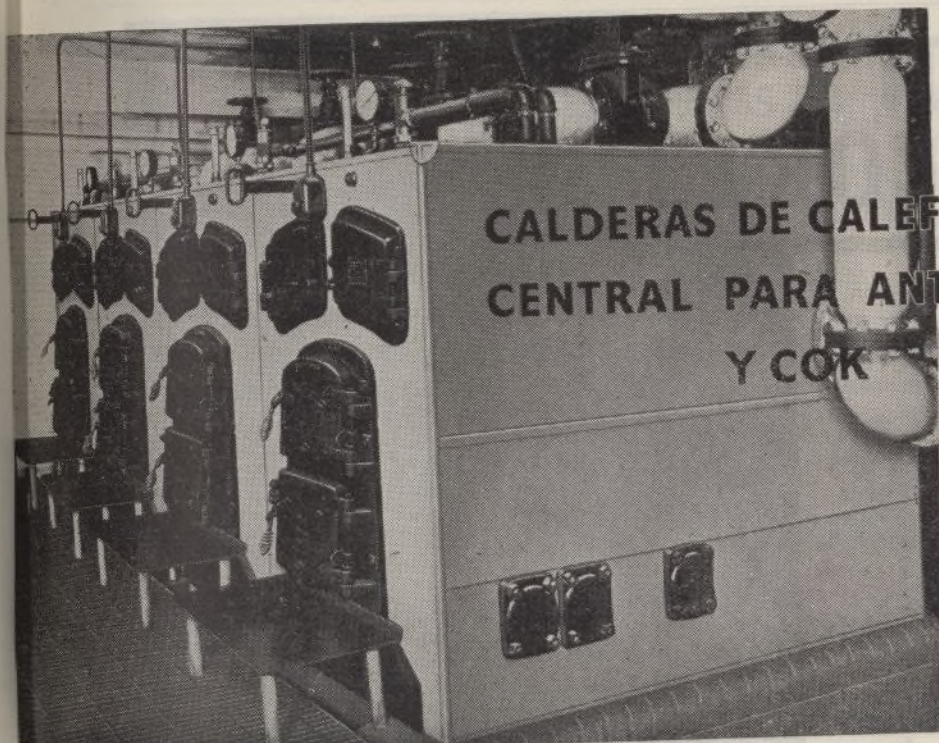
Calderas británicas (seccionales) de calefacción central instaladas en un hospital.
