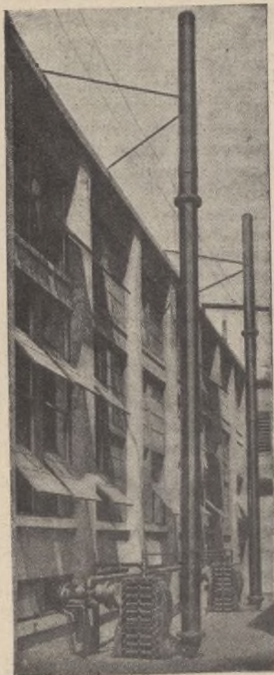
Fig. 6. —Calentadores y tubos de escape.
