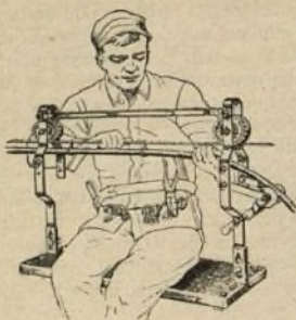
Fig. 2.—Operario utilizando el carro para la reparación de un cable.
