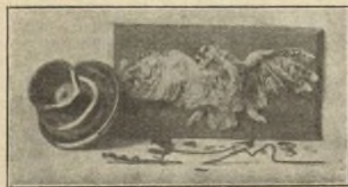
Fig. 2.—Lechuza que originó disturbios en una línea a 35.000 voltios
