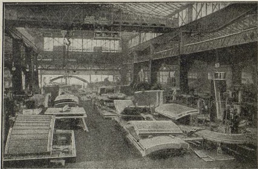
Taller de ajuste de las placas de blindaje para acorazados.
