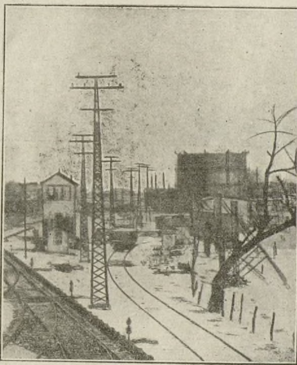
Postes de acero para líneas a 11.000 voltios y otros conductores.
