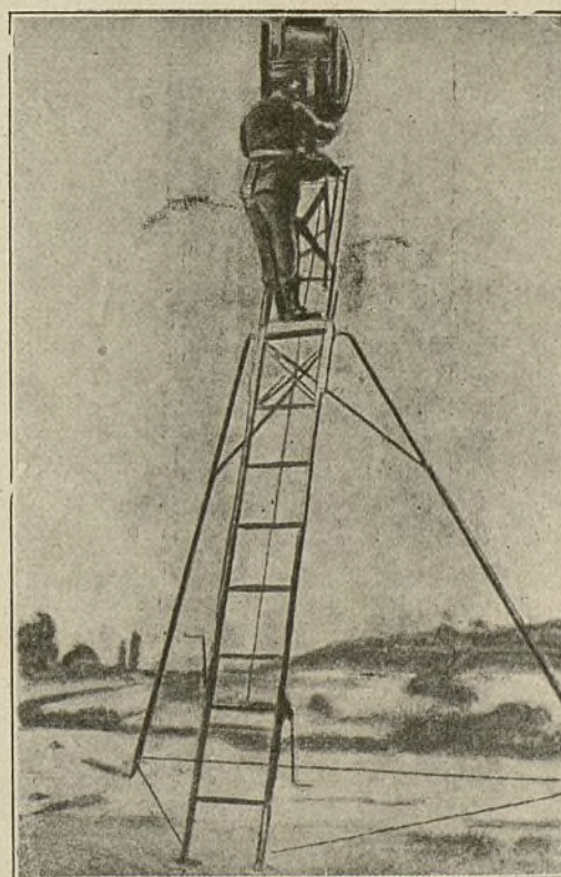
Fig. 13. — Reflector de 60 cm. sistema Sautter-Harlé, empleado por el ejército francés.
