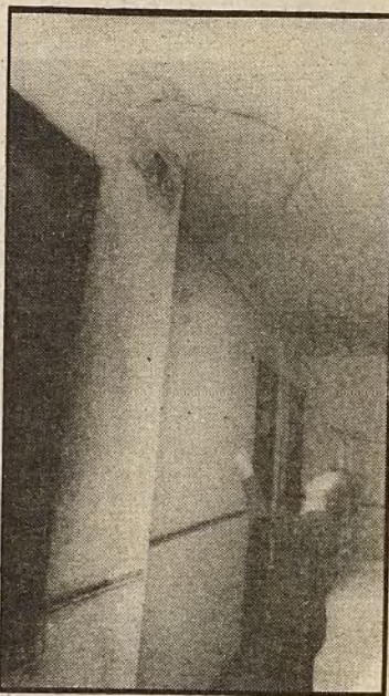
A pesar de las obras realizadas por el Ministerio de Transportes, a requerimiento de la Junta Municipal de Chamartín, continúan las grietas y la humedad
