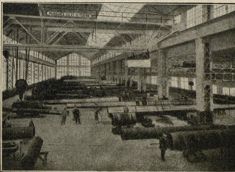
Cañones de 340 y 381 milímetros en construcción en los talleres del Creusot.
