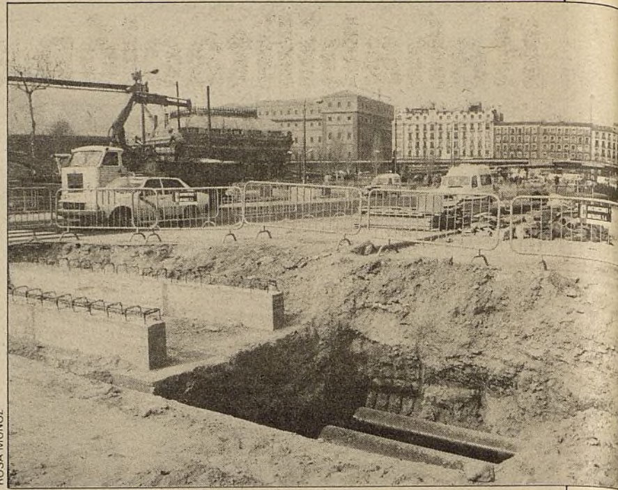
En la actualidad se procede al cambio de sitio de los servicios de agua, gas, teléfonos y electricidad
