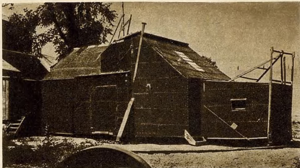
El primer taller de cine de Edison, conocido en la historia de este arte con el nombre de "Black Maria". Estaba erigido en una plataforma giratoria para recibir del sol la mayor suma de luz posible durante la filmación.
