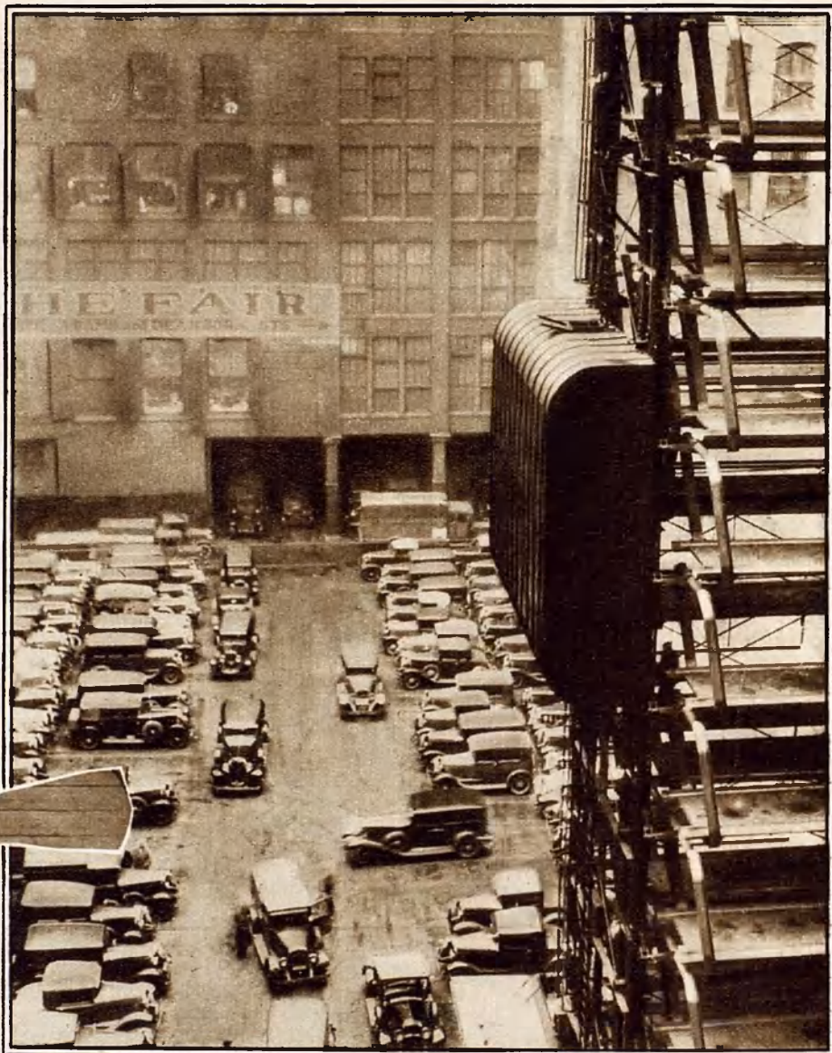
En Chicago han adoptado este sistema de garages sintéticos para resolver el problema de guardar los autos mientras no andan atropellando gente por ahí. Esta construcción está en el centro de la urbe y tiene capacidad para 48 coches, en estantes.
