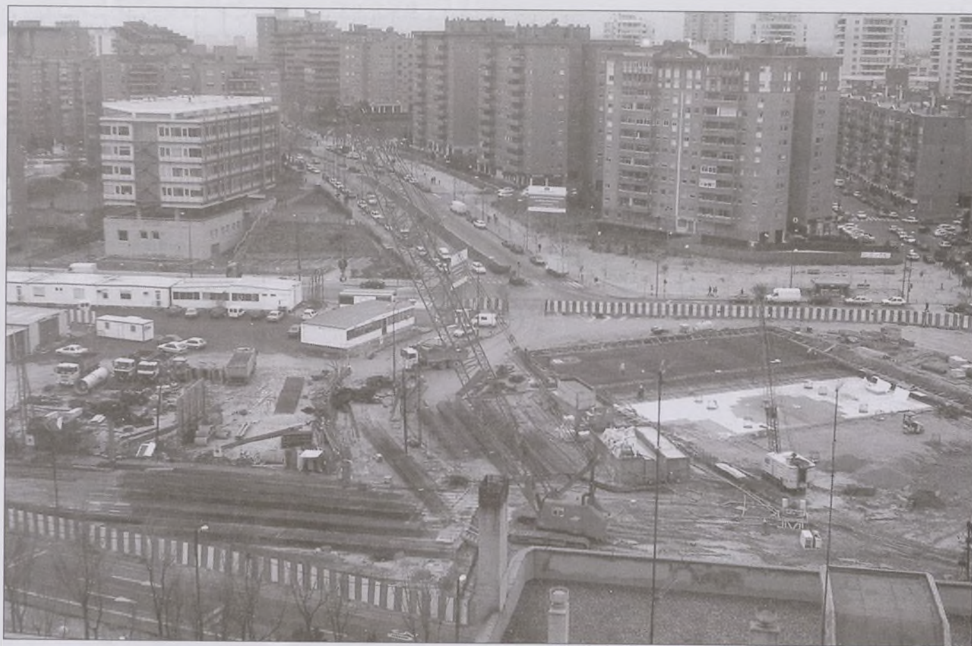
Vista aérea de la plaza de Mar de Cristal, centro neurálgico de las obras del metro. A la derecha de la foto va la nueva estación. Delante de las casetas y del Laboratorio Municipal, a la izquierda de la foto, comienza la línea 8 a los Recintos Feriales. Por ahí entrará el topo que va a hacer el túnel por debajo de la M-40.
