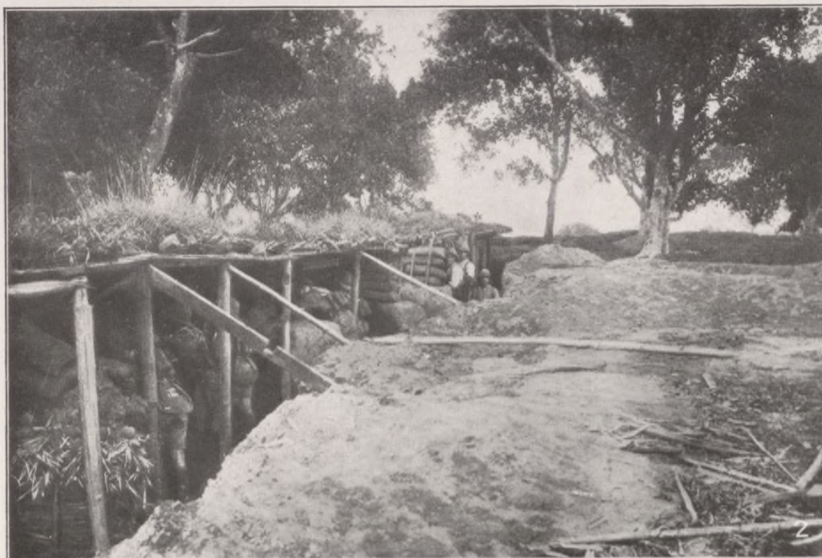
La campaña en Africa S.O.—1. Una trinchera descubierta con refugio a prueba de bomba en su extremidad derecha. 2. Trincheras cubiertas en vía de quedar terminadas.
