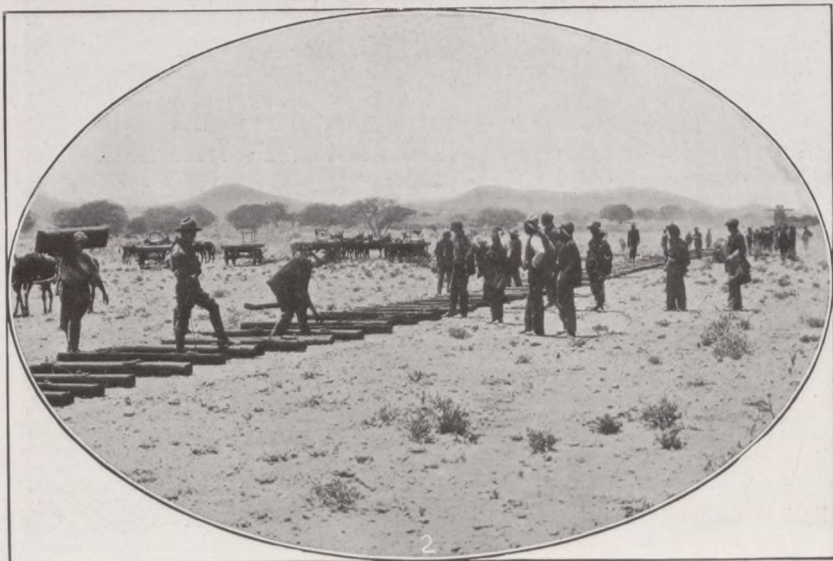
La campaña en Africa S.O.—(1) Despejando una vía y (2) Tendiendo traviesas para un ferrocarril.
