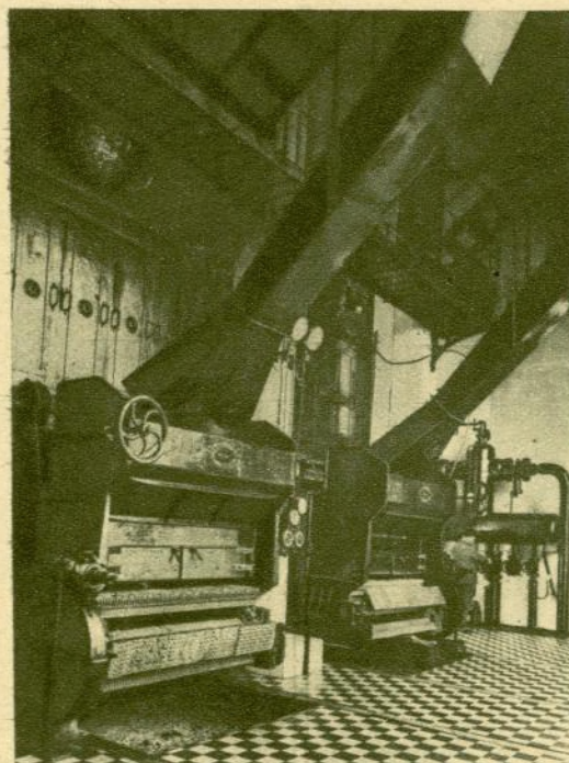
La caldera automática de la calefacción.
