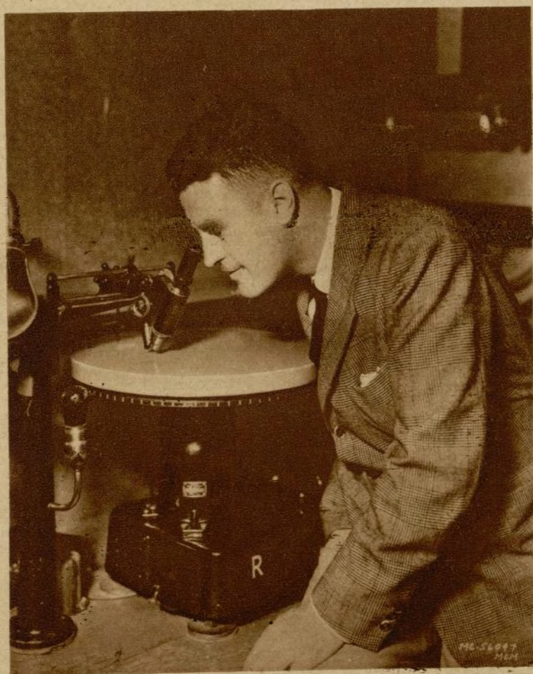
Douglas Shearer, jefe del departamento de impresión sonora en los estudios M. G. M., examinando con el microscopio un disco de los que se utilizan para grabar el sonido.
