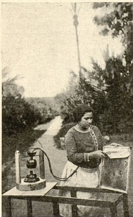
Práctico dispositivo ideado por D. José Chocomeli para la utilización del cuchillo de desopercular a vapor «Tonelli».
