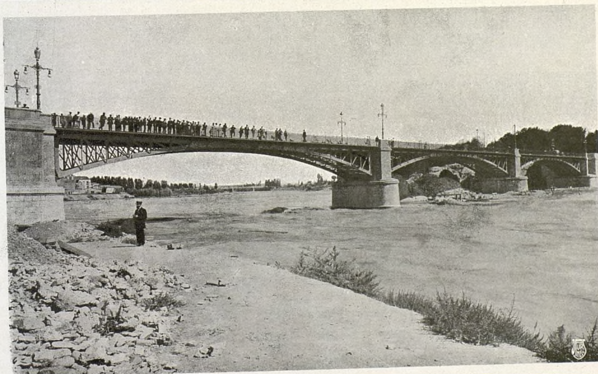
LÉRIDA.—Puente sobre el río Segre. Consta de tres arcos de acero. Cada tramo tiene 44 metros de luz.
