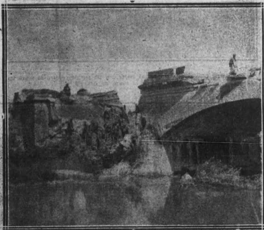
Ingenieros americanos reparando un puente volado por los alemanes en su retirada.
