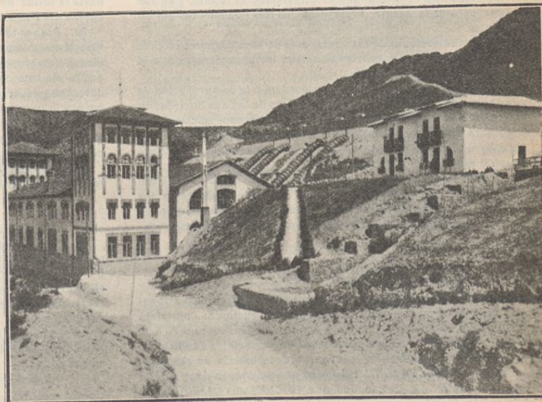
Salida de una de las líneas de 50.000 voltios. (Nótese la extraordinaria solidez de las columnas.)
