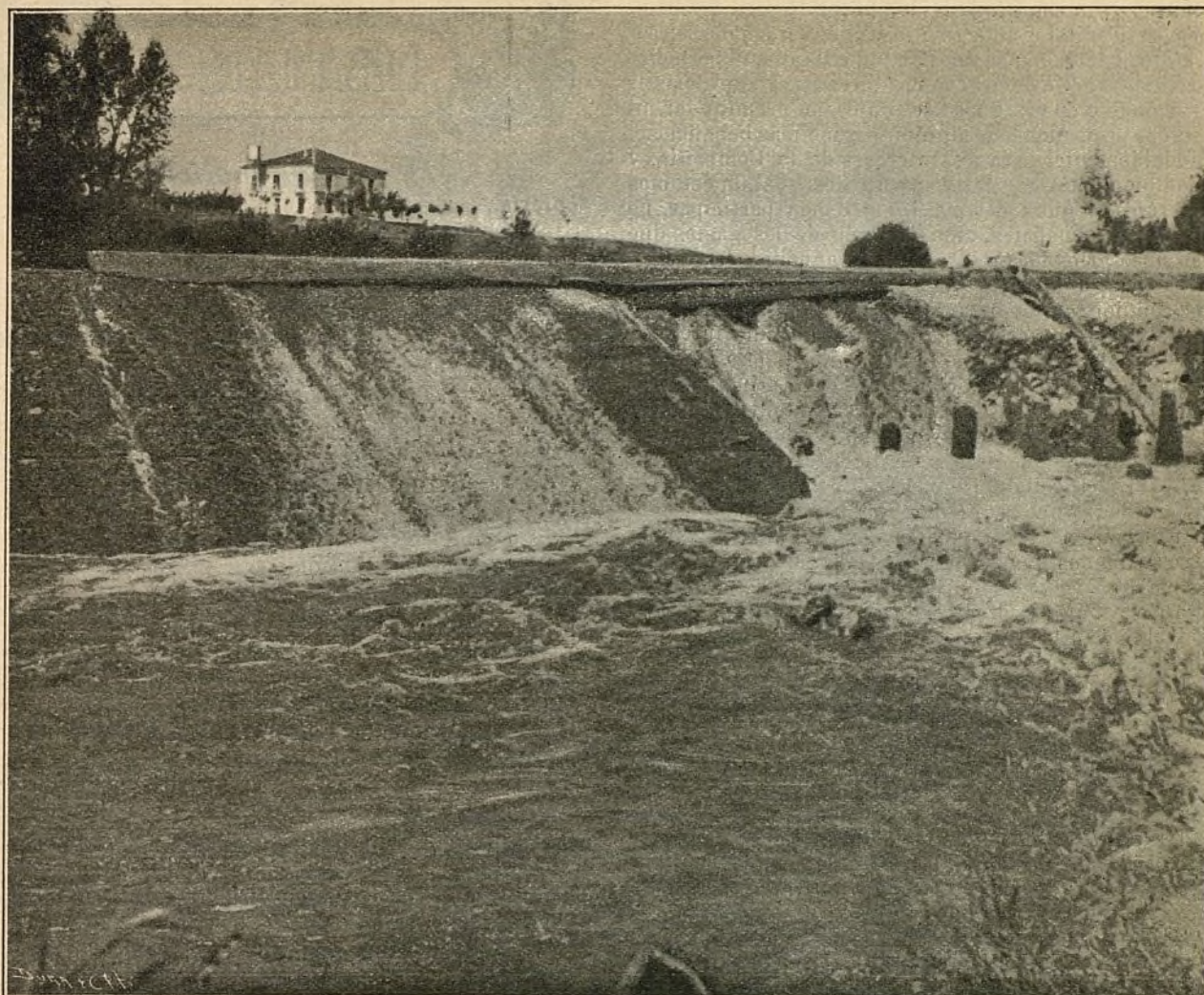
OTRA ROTURA DE LA PRESA DE SAN FERNANDO DE JARAMA
