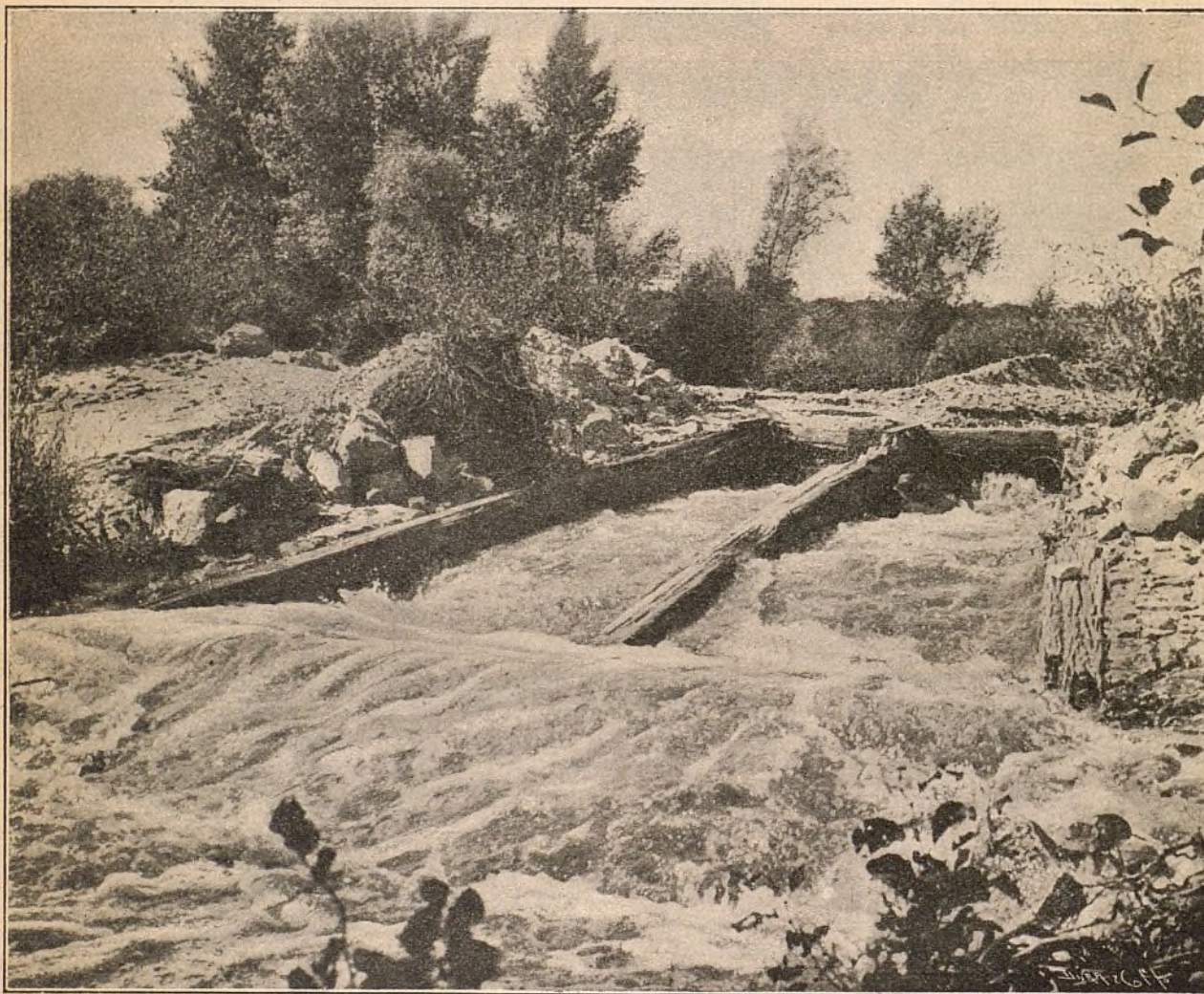
UNA DE LAS FUGAS DE LA PRESA DE SAN FERNANDO DE JARAMA
