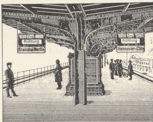
Estación provista de indicadores eléctricos de salida de trenes
