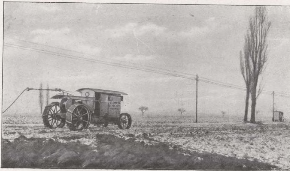
Carro de tambor funcionando con línea de alta tensión y transformador transportable conectado
