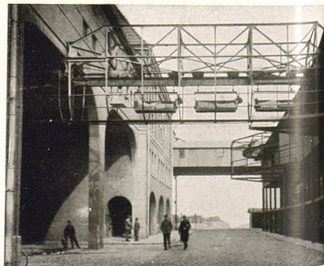
Fig. 14: Ferrocarril eléctrico suspendido para transportar sacos vacíos
