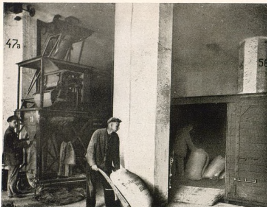
Fig. 12: Ensacando y pesando los cereales en balanzas automáticas para embarcarlas en vagones de ferrocarril
