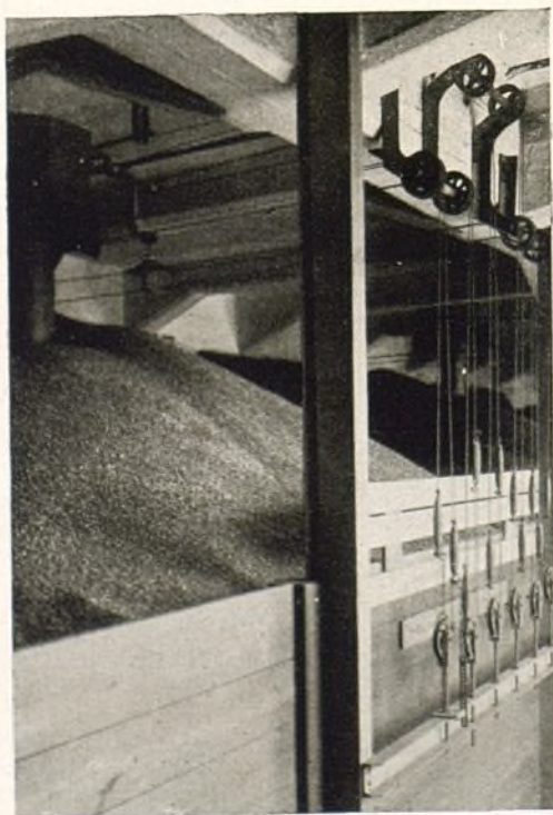
Fig. 11: Piso de depósito con instalación de tubos de caída
