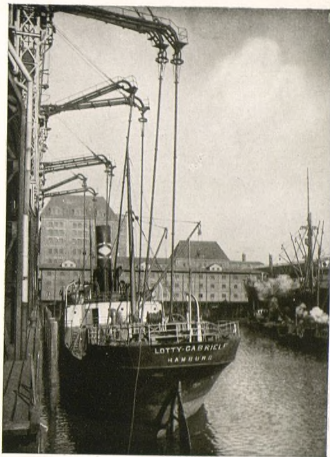
Fig. 3: Descarga de un vapor de cereales por medio de aire de aspiración
