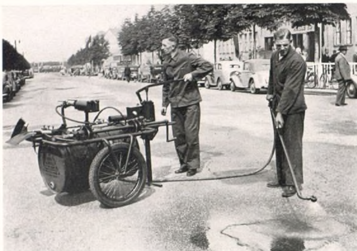
Feria de Leipzig — Con este sencillo y manejable aparato, fácil y rápidamente pueden llenarse los baches en el pavimento de las calles y carreteras
