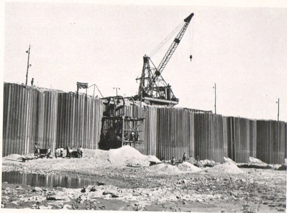
La zanja con bombas de desagüe
