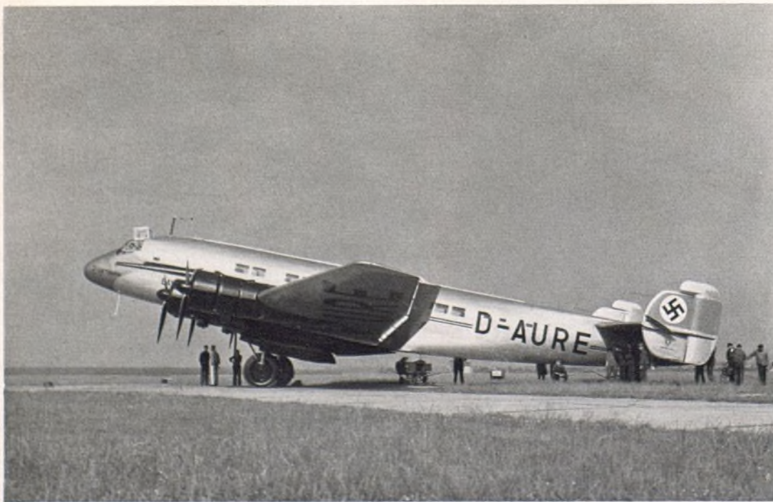
El Junkers-Ju 90, avión de 4 motores para 40 pasajeros, de un peso de 21/23 tons., que desarrolla una velocidad máxima de 400 kms./hora y una media de 350 kms./hora, dotado de los famosos motores a aceite crudo Junkers-Jumo-211
